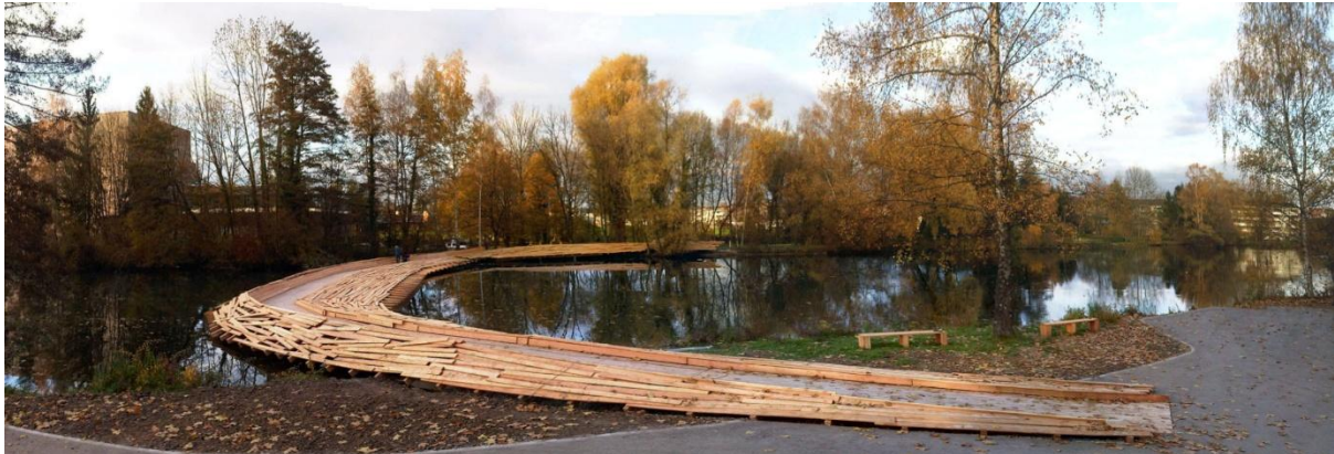
Die Kawamata-Brücke in Uster – das Wahrzeichen unserer KI-Lernreise.
