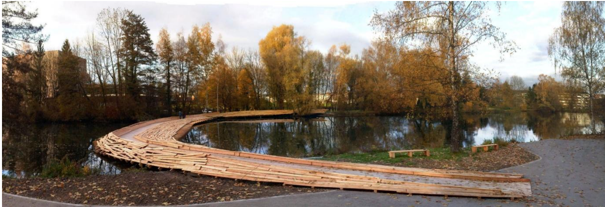
Die Kawamata-Brücke in Uster – das Wahrzeichen unserer KI-Lernreise.
